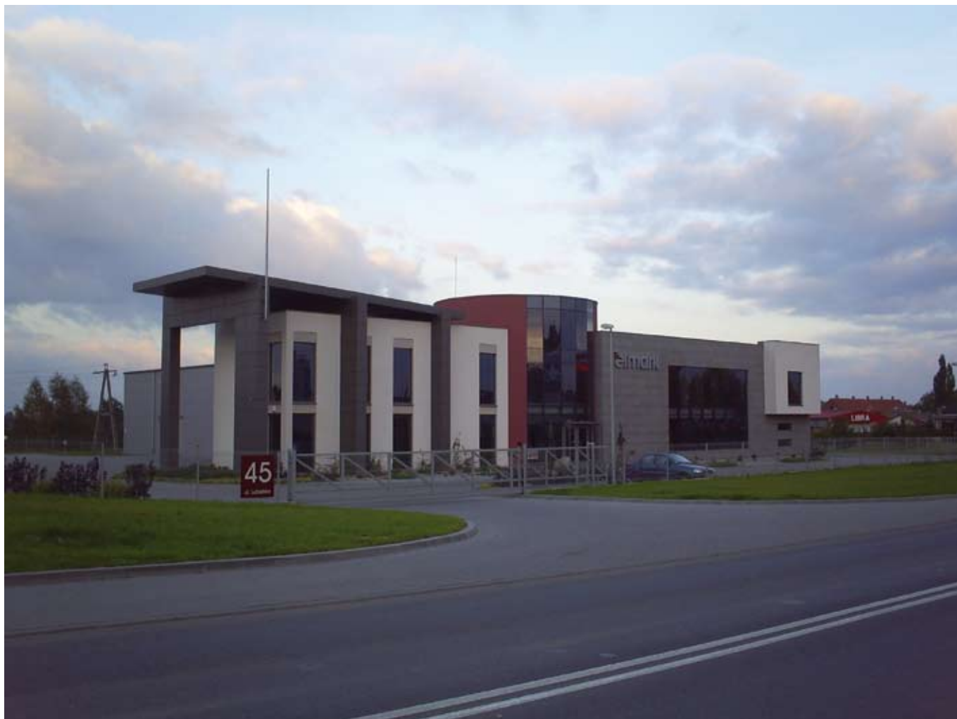
Hurtownia Elektryczna ELMARK - Olsztyn
